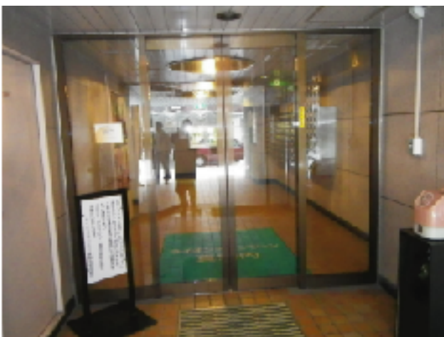
改修前のエレベーターホール
