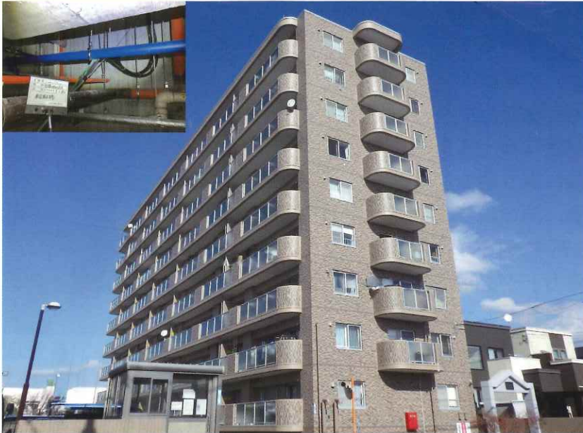
グランコート北27条大規模修繕工事および給水設備改修工事
