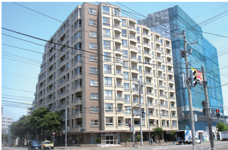
九条橋ハイホーム外壁等大規模修繕工事
