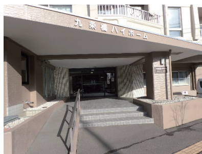
玄関アプローチ 完成
