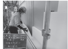
外断熱改修工事(外壁)
