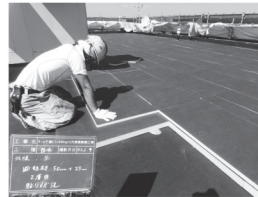
外断熱改修工事(屋上)
