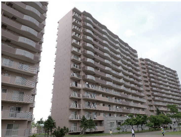
中銀ヴェルデシティあいの里 4・5号館大規模修繕工事
